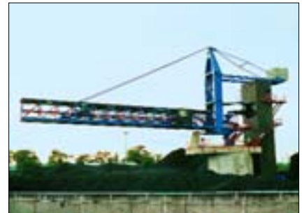
Apilador de carbón en una central eléctrica
