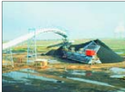
Parque de almacenamiento circular de carbón (industria minera)
