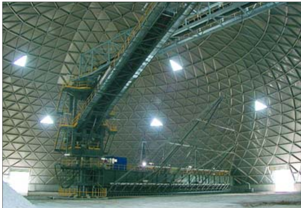
Plataforma circular de mezclado para mezcla cruda de fabricación de cemento
