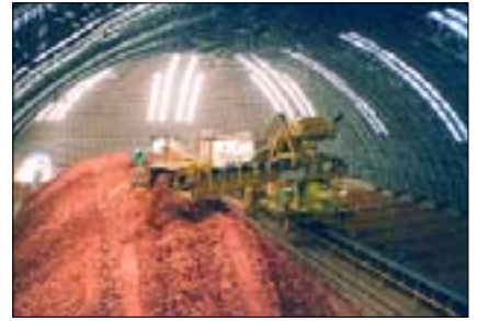
Plataforma longitudinal de mezclado: apilador giratorio
