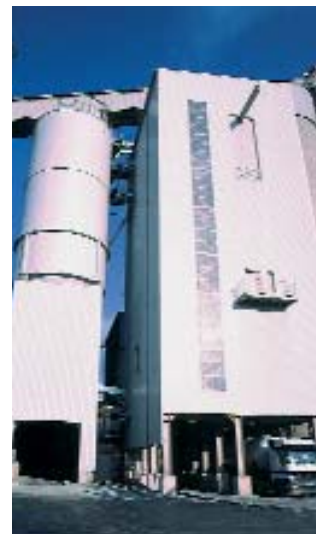
Planta de Mistura de materiais de construção para 180 t/h
