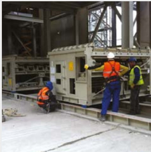
Instalación del Enfriador ETA.
