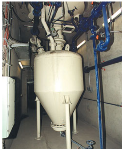
Transporte de cenizas mediante recipiente a presión.
