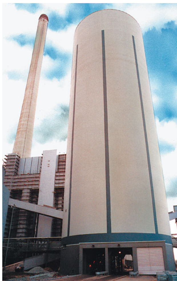
Claudius Peters – Silo de doble cámara (31 m de diámetro) con instalaciones de carga de camiones.
