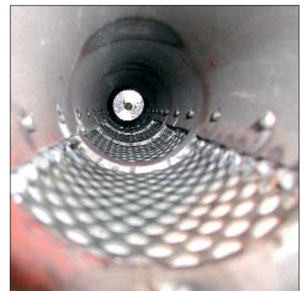
Vista de la tubería de aireación FLUIDCON
