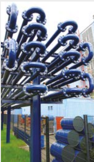
5.000 m de longitud de tuberías de transporte.
