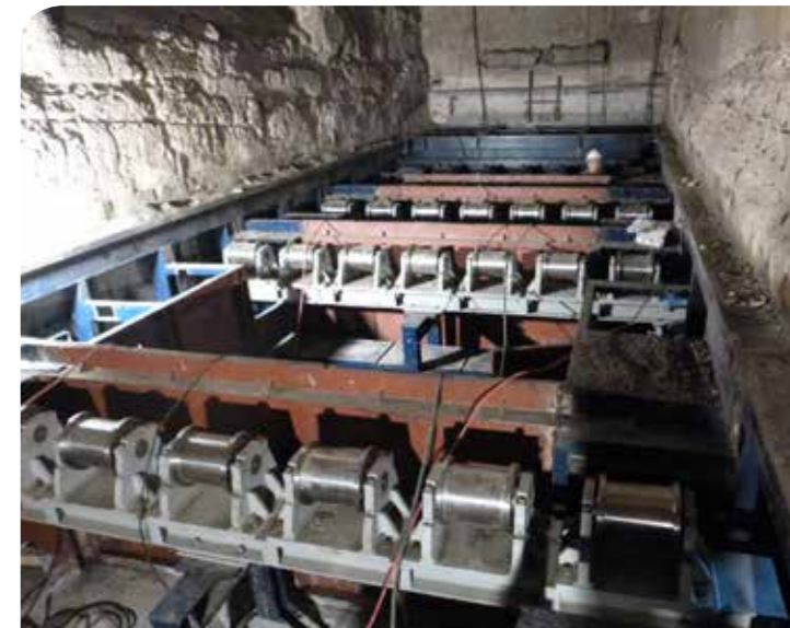
Figura 4. Enfriador preparado para la instalación de los carriles.
