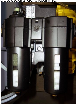
maintenance préventive par unité d'air conditionné
