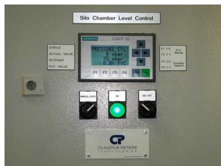
③ Panneau de contrôle local
