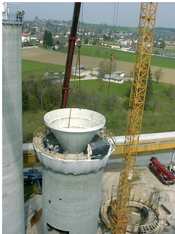
Silo CC dans un silo enveloppe béton
