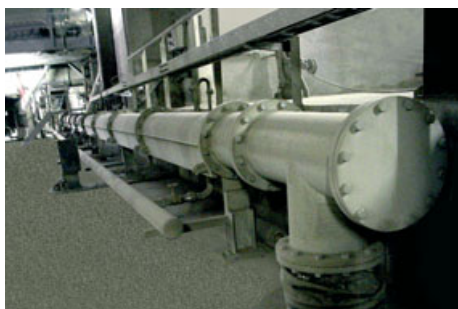
Sistema de transporte FLUIDCON na planta Lägerdorf da Holcim, para 230 t/h de cimento
