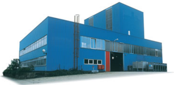
Centro Técnico em Buxtehude
