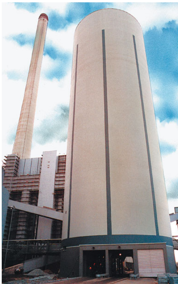
Claudius Peters – двухсекционный силос (диаметр 31 м) с устройствами для загрузки автоцистерн
