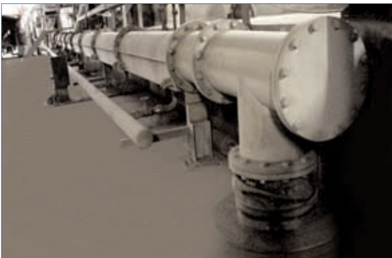
Система FLUIDCON для транспортировки 230 т/ч цемента на цементном заводе Holcim в Лэгердорфе
