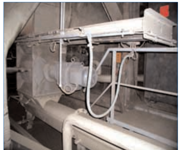
Система FLUIDCON для транспортировки 230 т/ч цемента на цементном заводе Holcim в Лэгердорфе
