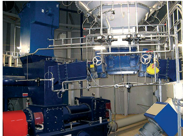
Питание пневмовинтового насоса типа X посредством разгрузочного оборудования Claudius Peters
