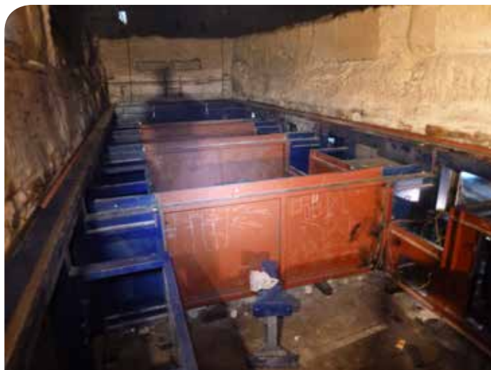
图3 - 风室安装完备之后的状态
