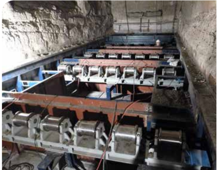
图4 - 安装列向单元之前的状态
