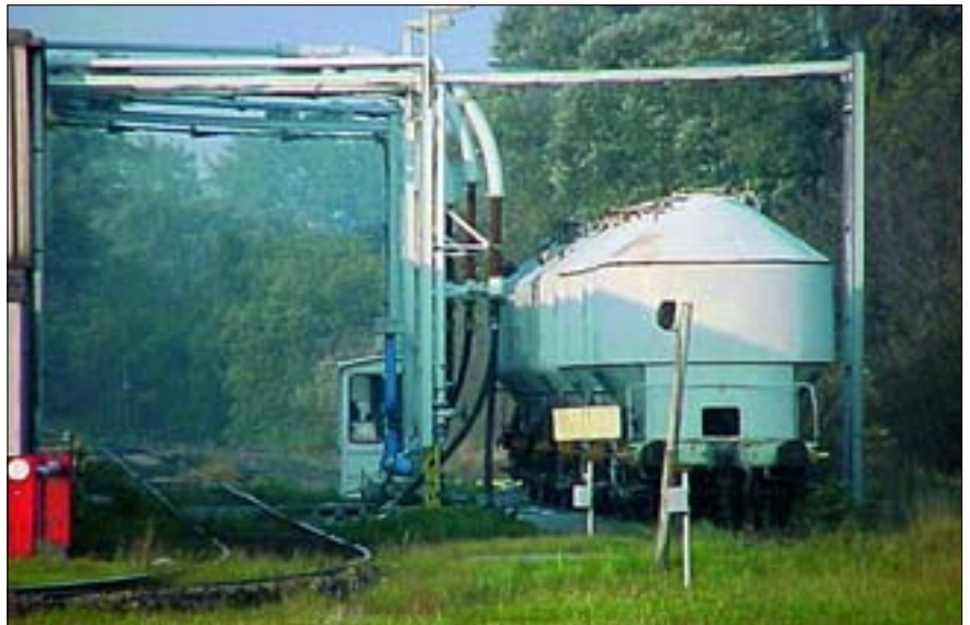
Eine automatisierte, gleichzeitige Entleerung mehrerer Wagons spart Zeit und Kosten
