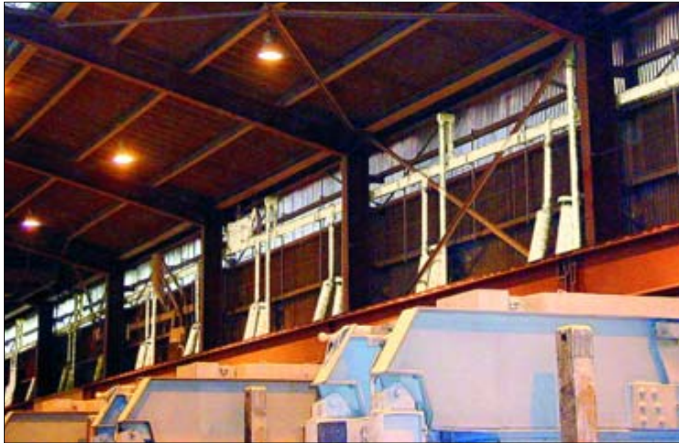
Die Versorgungsleitungen für Aluminiumoxid und Fluoride sind harmonisch in die Hallenkonstruktion integriert
