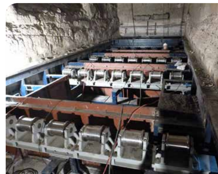
Bild 4: Kühler vorbereitet zur Aufnahme der Schubböden
